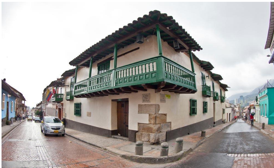
Ilustración 11: Foto No 7 Fachada Sede Casa Principal
