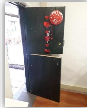
Ilustración 13: Foto No 9 Puertas del depósito de
